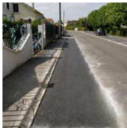
Chaussée rue du Pont Saint-Jean
