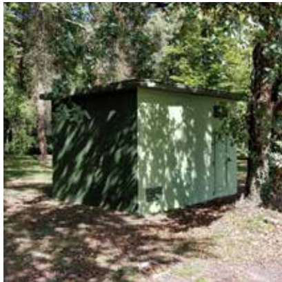
Peinture du poste électrique du Bois Saint-Jean
