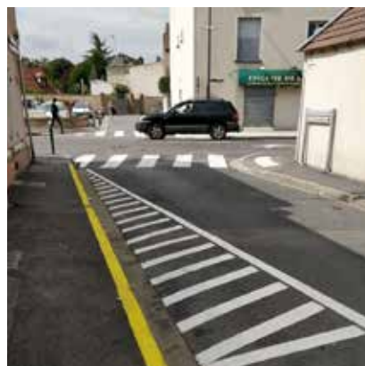
Zébras et trottoir rue Dauphine
