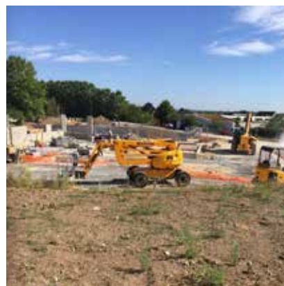
Travaux du collège
