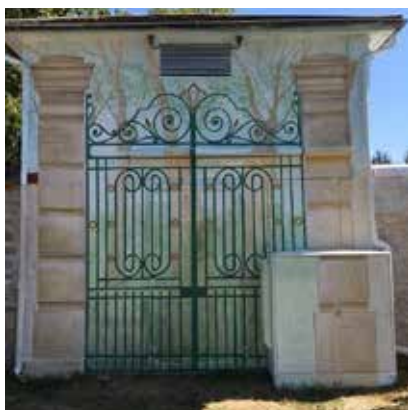
Trompe-l'œil du poste électrique de la mairie (face)
